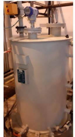
Füllstandmessung von HCl mit dem OPTIFLEX 7200
