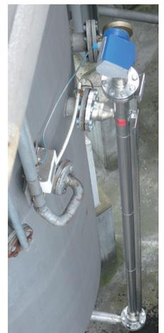
Medida mediante bypass en un tanque de 2 cámaras
