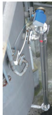
Détection de niveau en dérivation sur un réservoir à deux chambres
