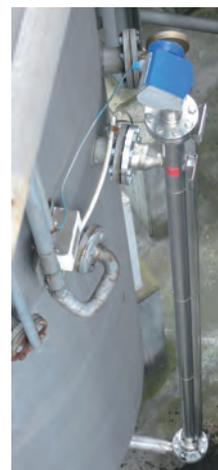
Bypassmessung an einem 2-Kammer-Tank
