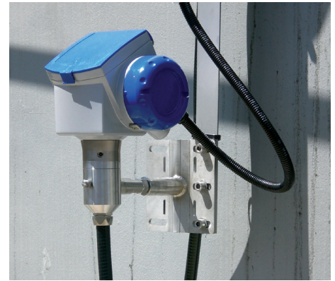
Messumformer in getrennter Ausführung
