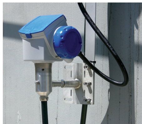
Le convertisseur de mesure déporté à la hauteur des yeux
