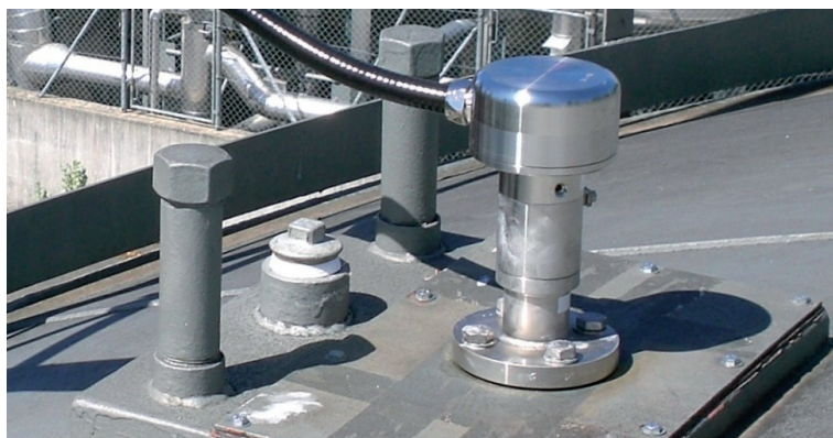
L'OPTIFLEX 1300 en version séparée avec la sonde installée sur un réservoir
