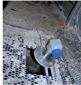
OPTIWAVE auf einem Kiessilo
