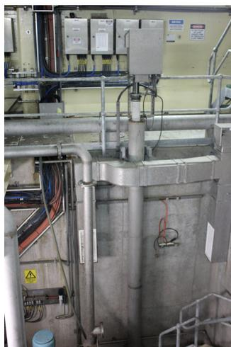
OPTISYS SLM 2100 на приемном бункере первичного отстойника
