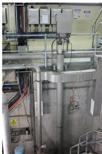
OPTISYS SLM 2100 monté sur une trémie d'un réservoir de sédimentation primaire
