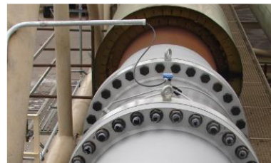
Durchflussmessung von Heißwasser mit dem OPTISONIC 3400
