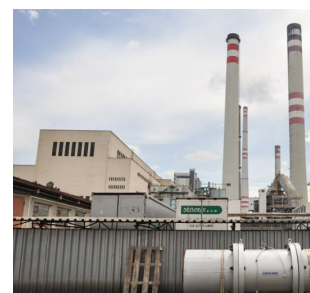
Centrale à charbon
