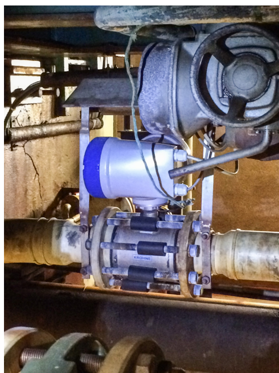
Měření průtoku elektrolytu průtokoměrem OPTIFLUX 5300 (magneticko-indukční průtokoměr)
