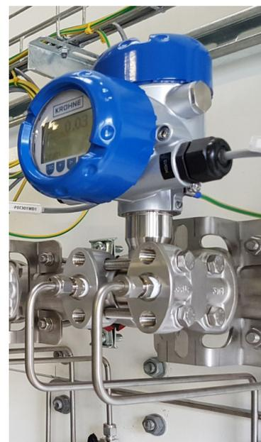
DP-Messumformer mit Montagehalterung an der Wand befestigt
