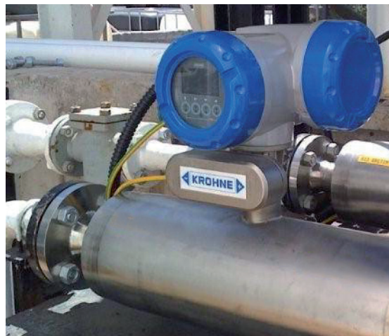
El OPTIMASS 7300 C con medida de la concentración integrada
