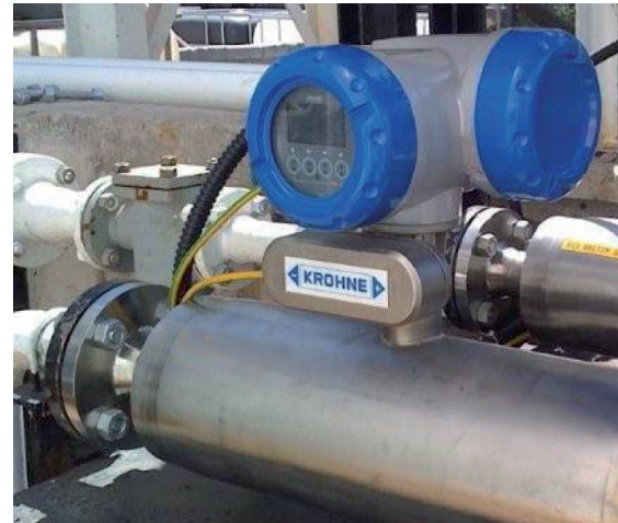
Masse- und Brix-Messung von Zuckersaft mit dem OPTIMASS 7300 C
