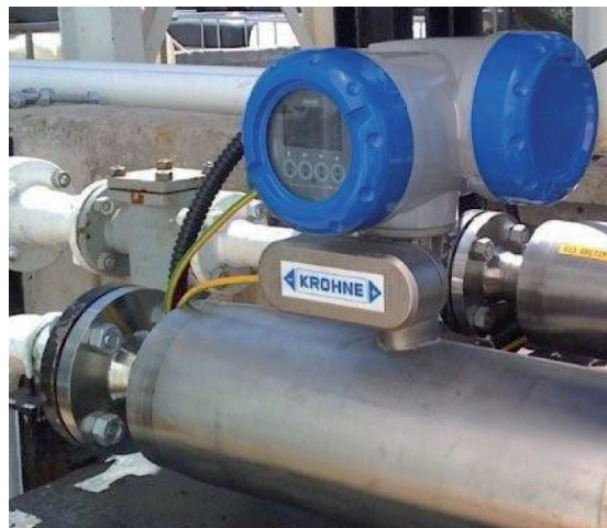
Le débitmètre massique OPTIMASS avec mesure intégrée du degré BRIX
