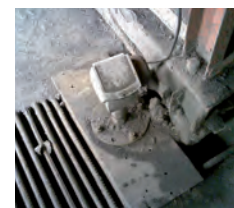
L'OPTIWAVE sur un silo
