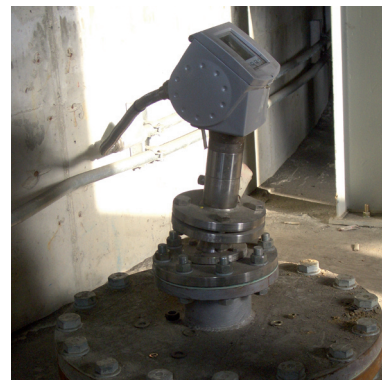
Contrôle du silo à houille
