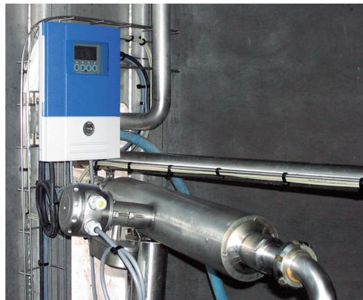
Masse-Durchflussmessgerät OPTIMASS 7300 W
