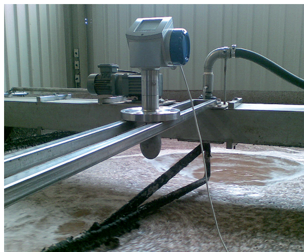
Cuando se forma espuma debajo del equipo de medida, se activa el mecanismo de retirada de espuma
