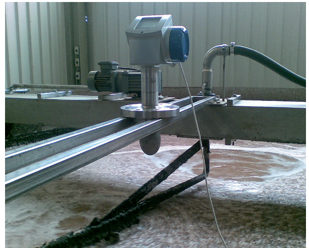
Bei Schaumbildung unter dem Messgerät wird der Schaumabzug ausgelöst
