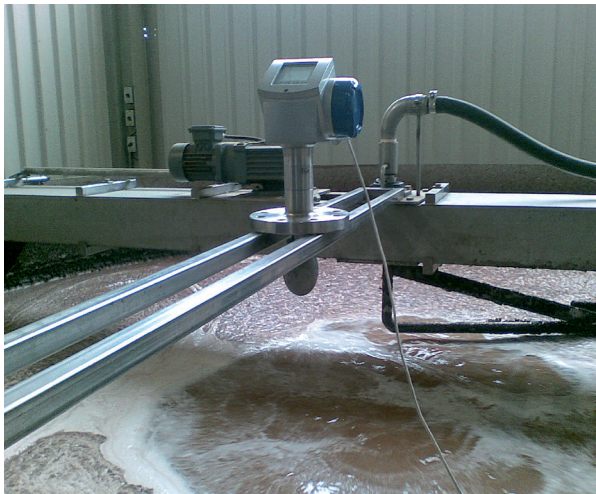
Der OPTIWAVE 7300 erfasst die Reflektivität der Produktoberfläche
