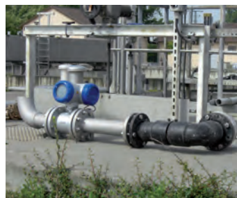
Instalación para la prueba en una planta de tratamiento de aguas residuales
