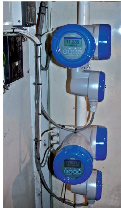
Getrennt montierte Messumformer
