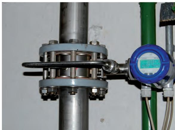
Eingeschnürte Rohrleitung für die Durchflussmessung
