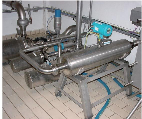
Masse- und Dichte-Messung von Salzlake mit dem OPTIMASS 7300 C
