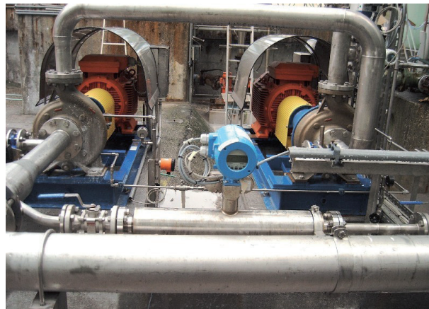
OPTIMASS Masse Durchfluss-Messgeräte bei der Dichte-Messung
