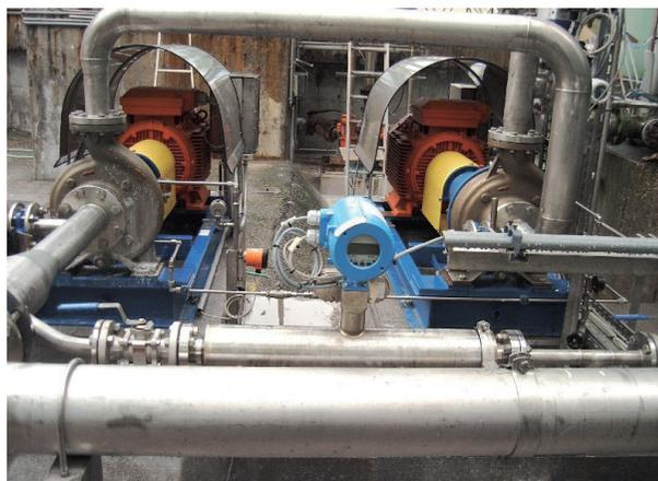
Débitmètres massiques OPTIMASS mesurant la masse volumique
