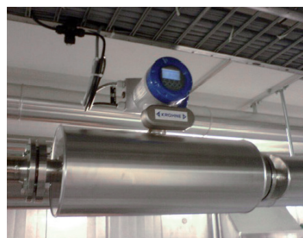
OPTIMASS 1300 C in einer Speiseöl-Rohrleitung
