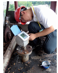
OPTIWAVE 6300 C Installation auf dem Silodach
