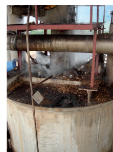
Toit du silo
