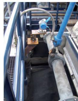
Die Abstandmessung springt mit der Unterfahrt der Maschine und der Füllung der Bunker binnen kurzer Zeit von 9 m auf ca. 1,5m
