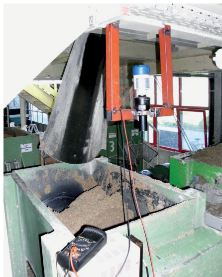
Automatisierte Befüllung: im Hintergrund ist die Befüllrampe zu sehen.
