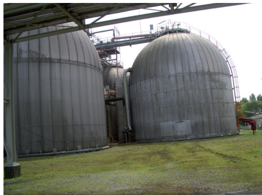
Сферические резервуары для хранения хлора можно заполнять только до предварительно заданной высоты
