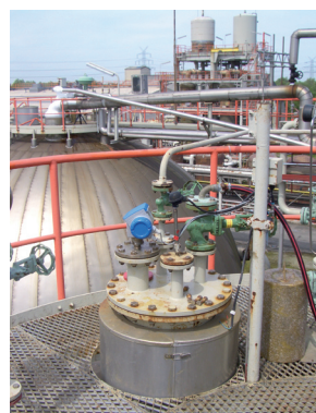
Montage de l'OPTIWAVE 7300 sur les brides existantes sur le toit du réservoir sphérique
