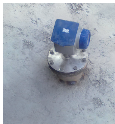
OPTIWAVE 6300 C installé sur le toit d'un silo
