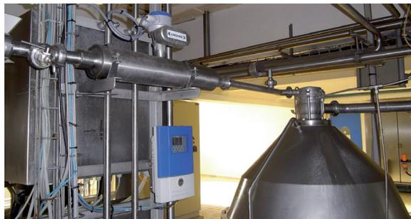
Fettstandardisierung mit dem OPTIMASS 7300 W
