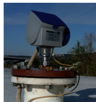
OPTIFLEX 1300 C в позиции измерения сверху сепаратора
