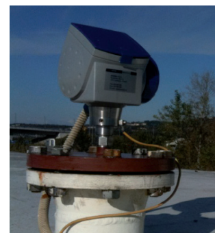
El OPTIFLEX 1300 C efectuando medidas encima de un separador
