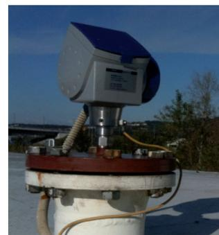
Der OPTIFLEX 1300 C im Einsatz auf dem Separator
