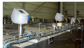
OPTIFLEX 1300 C на резервуарах хранения
