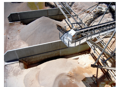
Förderband über offener Lagerhalde
