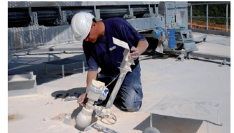
OPTIWAVE 6300 C (DN150) zur Messung des Füllstands in Betonsilos
