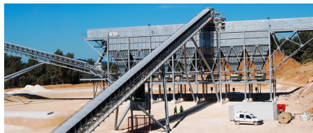
Silos de abastecimiento cónicos
