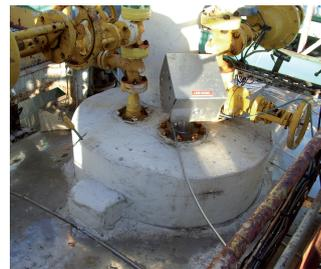
OPTIWAVE 7300 C измеряет уровень хлора бесконтактным способом
