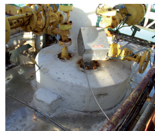
L'OPTIWAVE 7300 C mesure le niveau de chlore sans contact
