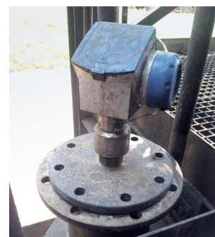
OPTIFLEX 1300 C montado con brida de nailon
