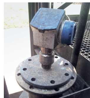
OPTIFLEX 1300 C monté avec bride en nylon
