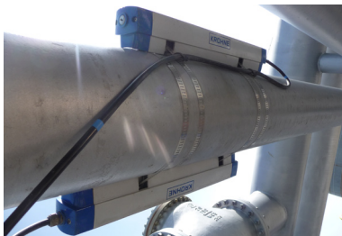
Clamp-On Durchflussmessgeräte an DN 200 Rohren aus Kohlenstoffstahl
