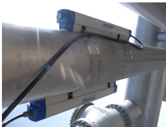
Débitmètres à montage externe montés sur des tuyaux en acier carbone DN 200
