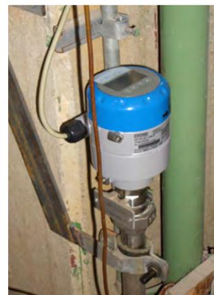
OPTIFLEX 1100 con conexión de proceso reducida
