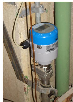
OPTIFLEX 1100 mit reduziertem Prozessanschluss
