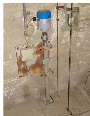
Installation im Schwallrohr
